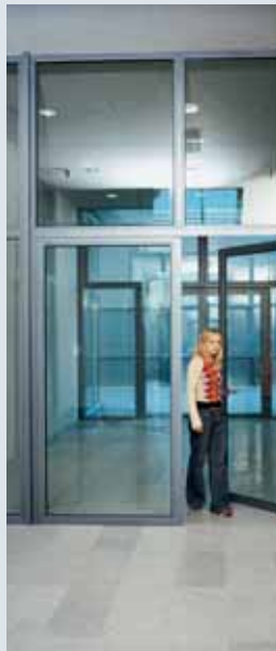
8 Σωληνωτά πλαίσια ελέγχου φωτιάς και καπνού
