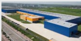
Hörmann Tianjin, Κίνα
