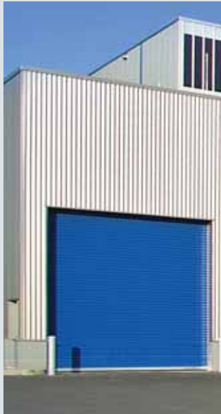
2 Πόρτες με ρολά και πόρτες με πλέγμα
